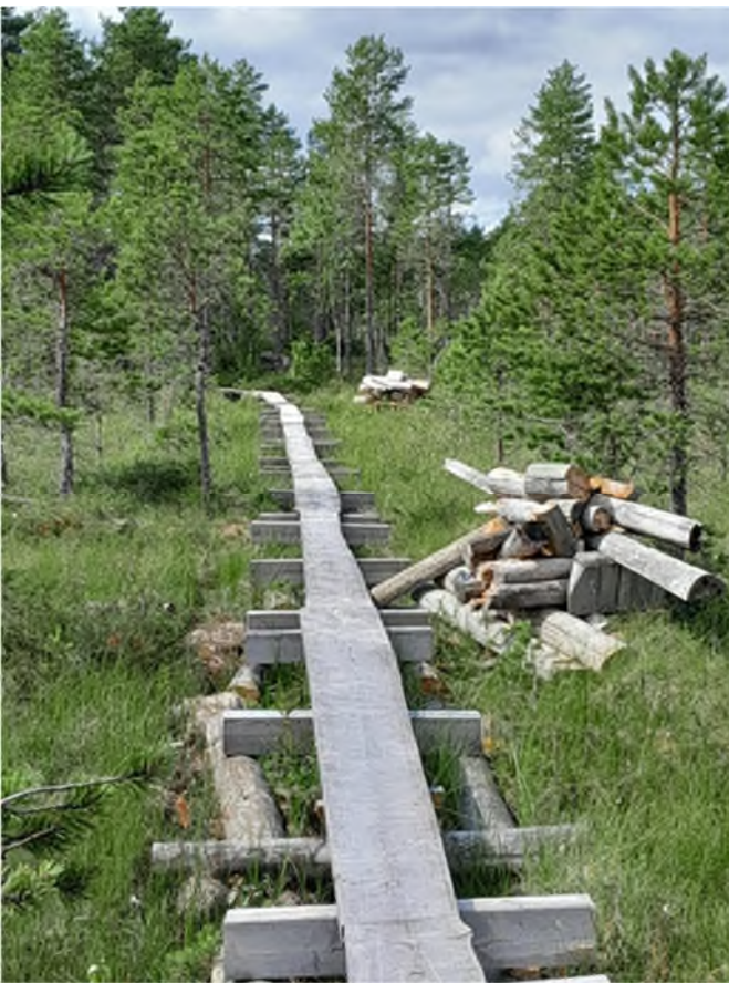
Pitkosten läjitys rakennusvaiheessa, siirto maastosta talvikeleillä
