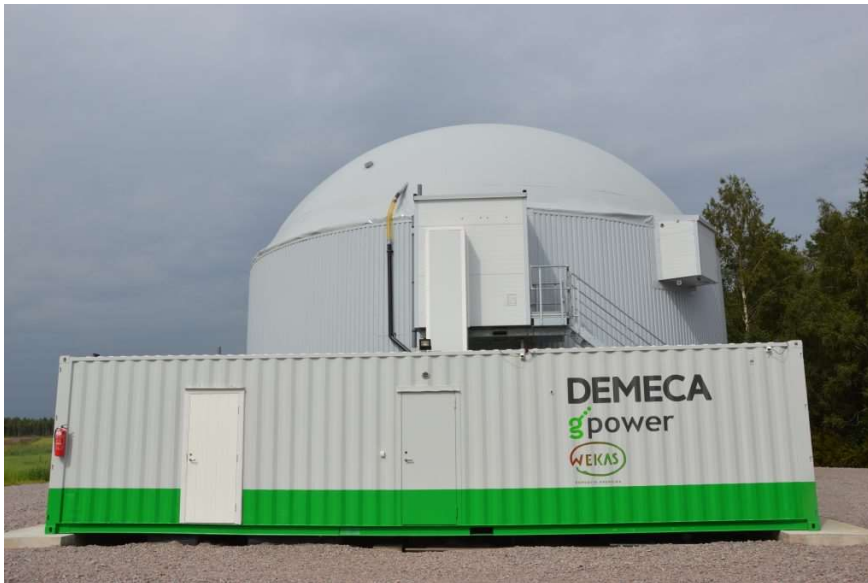
Kuva 5. Biokaasulaitos, Wekas Oy. https://demeca.fi/wekas/
